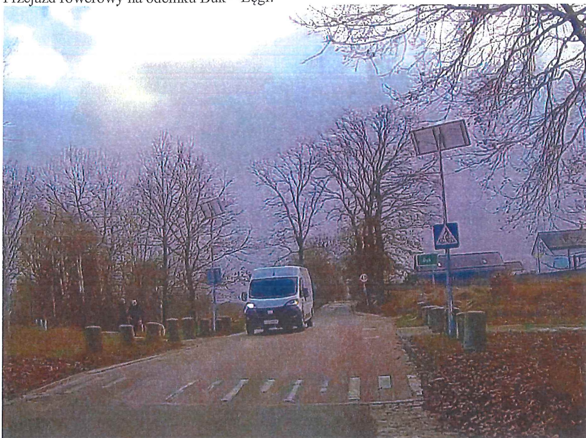
Przejazd rowerowy na odcinku Buk – Łęgi:
