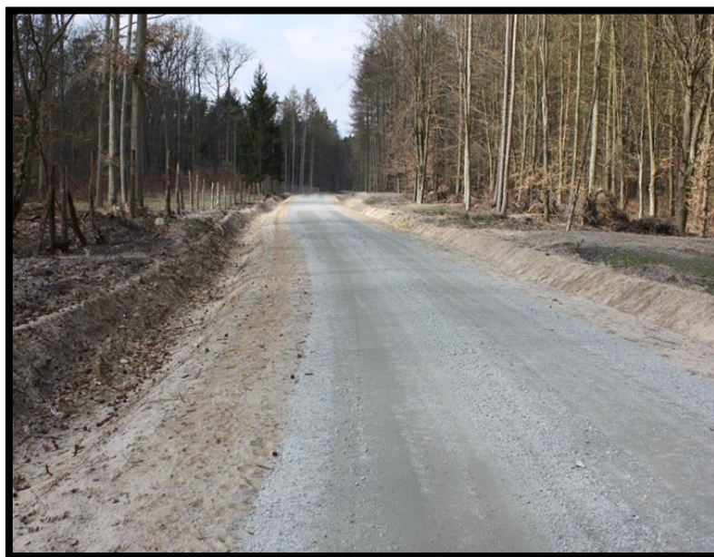
Fot. Nowobudowany dojazd pożarowy w Leśnictwie Siedlice.
