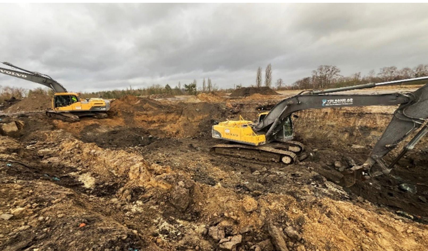
Widok terenu w trakcie prac remediacyjnych
